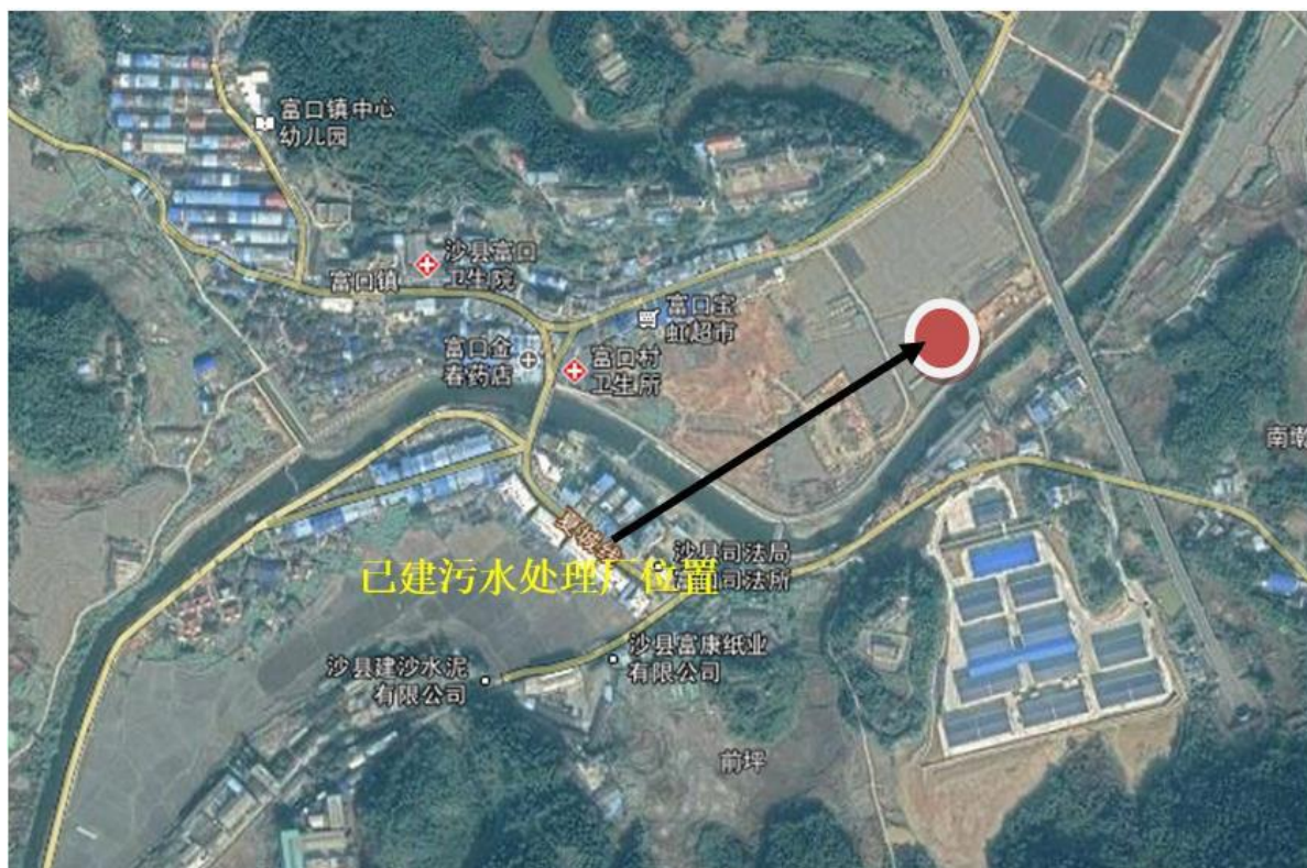
图 5.3-5 富口镇已建污水厂厂址
