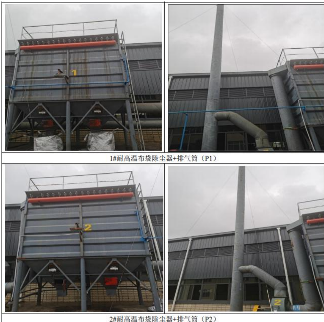
附图 6 现有工程推板窑尾气处理设施
