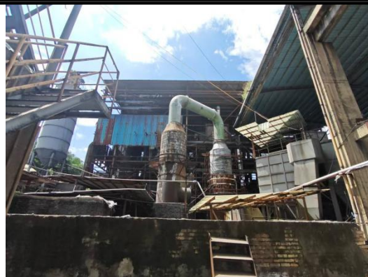
20t/h 燃煤蒸汽锅炉脱硫塔
