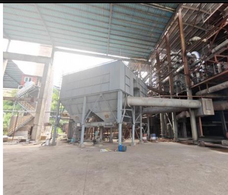
20t/h 燃煤蒸汽锅炉布袋除尘器
