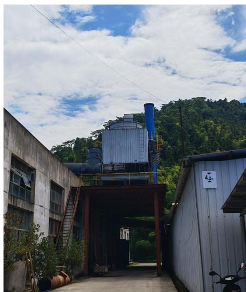
定型废气处理设施（喷淋+静电）
