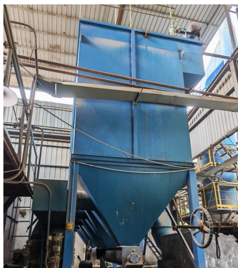
350 万大卡导热油锅炉布袋除尘器
