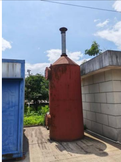
生物滤池除臭装置（排气筒高度为 8m，废气无组织排放）
