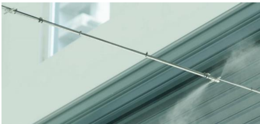
图 4.1-2 高压喷淋除臭系统示意图
