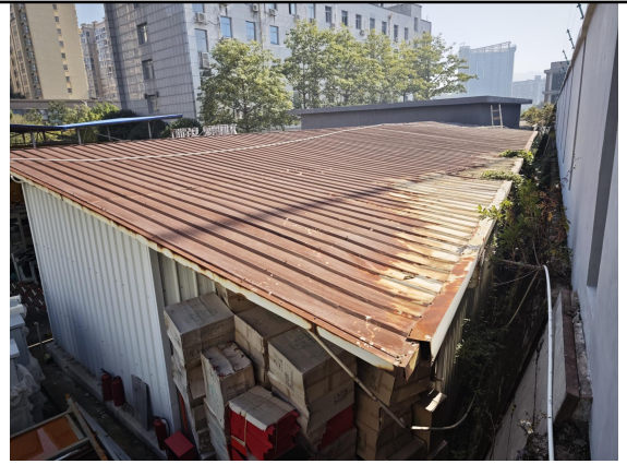
莲花 110kV 变电站东北侧现状
