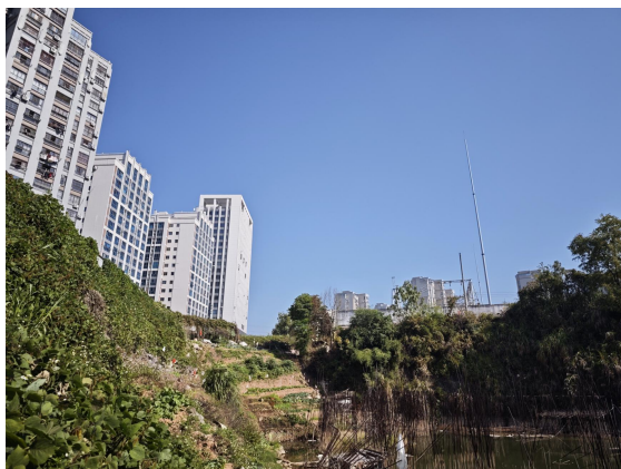
莲花 110kV 变电站东南侧现状
