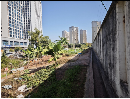
莲花 110kV 变电站西北侧现状
