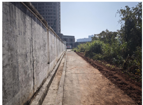
莲花 110kV 变电站西南侧现状
