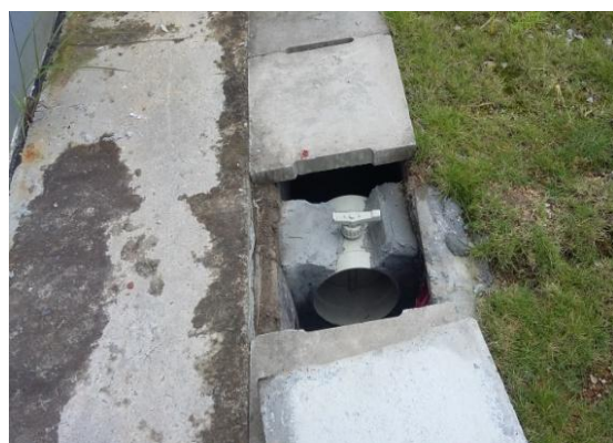
事故应急切换开关
