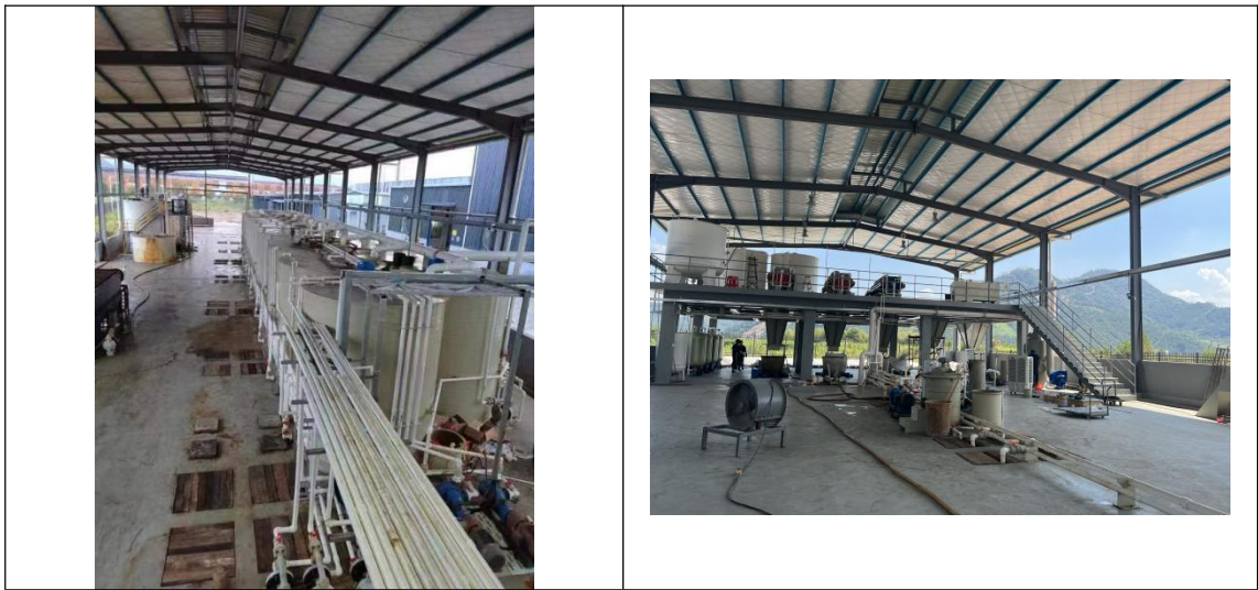
图 2-1 污水处理站现状图
