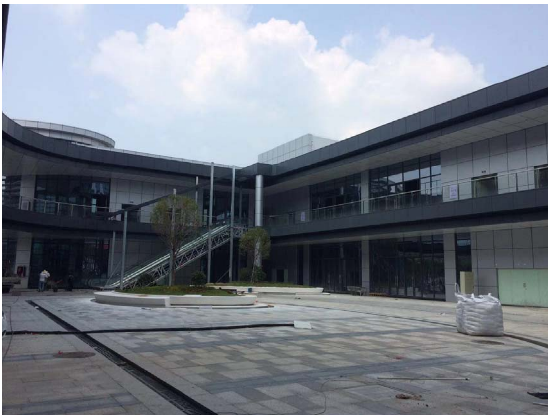
项目商业中庭景观绿化、带雨水篦子的排水沟
